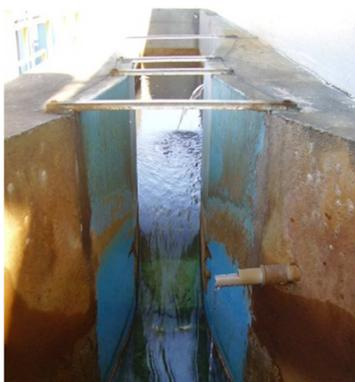
Figura 3.3 – Calha parshall na entrada de uma estação de tratamento de água
