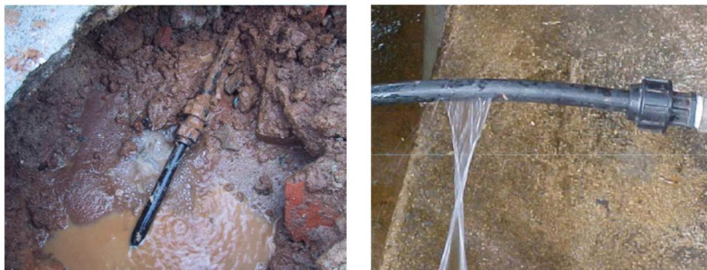
Figura 3.12 – Vazamentos em ramais
