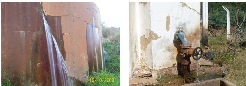
Figura 3.2 – Vazamentos em reservatórios
