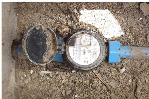
Figura 3.22 – Hidrômetro com mostrador ilegível
