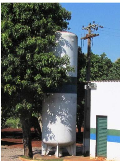
Figura 2.6 – Tanque hidropneumático
