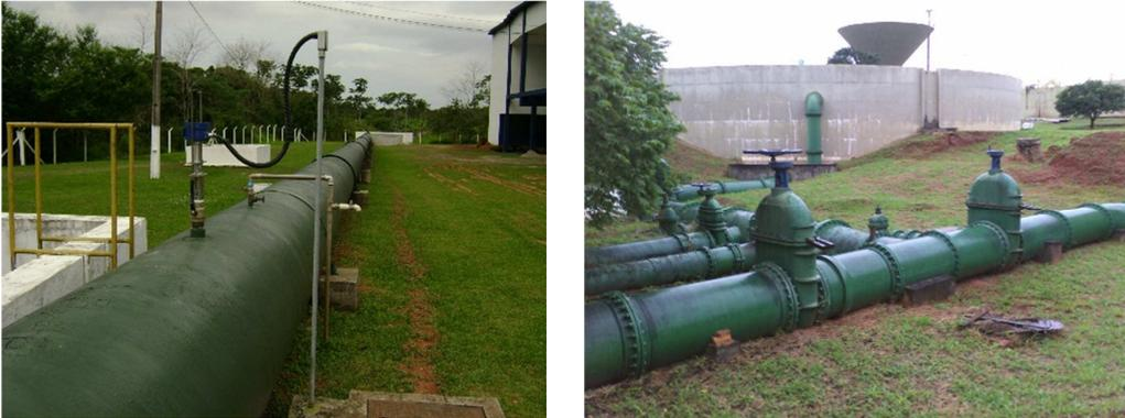
Figura 2.4 – Adutoras de água tratada por recalque e por gravidade
