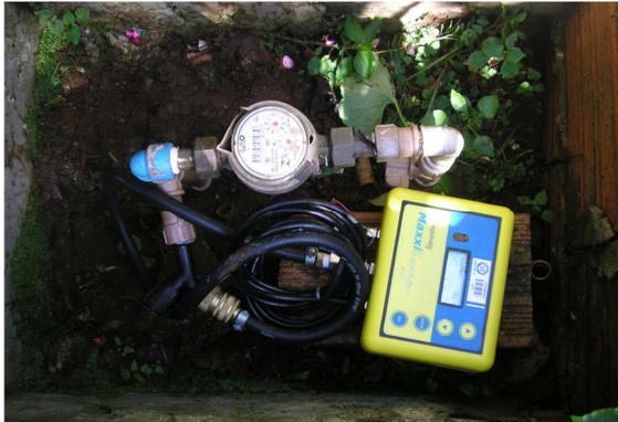
**Figura 3.18 – Medidor de pressão contínuo instalado na rede Piloto 1 (GIROL, 2008)**
