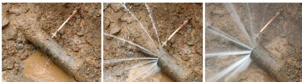
Figura 6.1 – Exemplo de influência da pressão em um vazamento (BROTHERS e LAMBERT, 2010)
