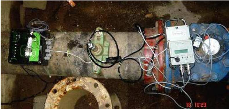
Figura 5.2 – Medidores de vazão e pressão instalados na entrada de um DMC (JACOB, 2006)
