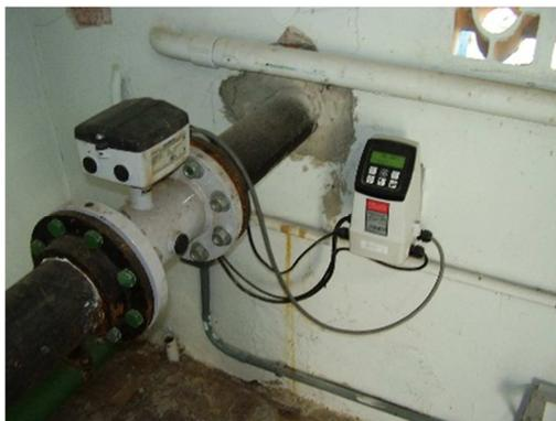
Figura 3.4 – Medidor de vazão eletromagnético na entrada de um DMC
