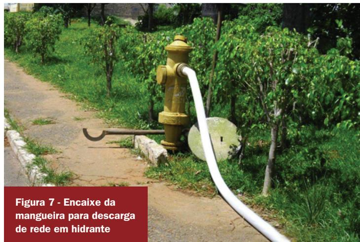
Figura 7 - Encaixe da mangueira para descarga de rede em hidrante
