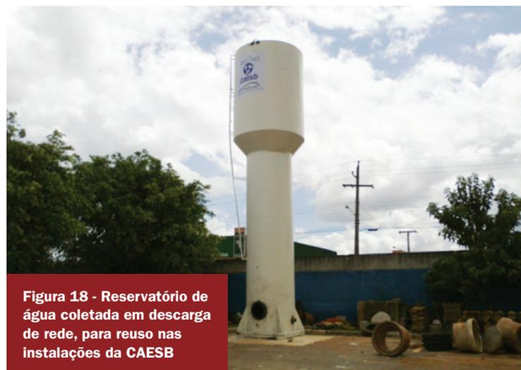
Figura 18 - Reservatório de água coletada em descarga de rede, para reuso nas instalações da CAESB
