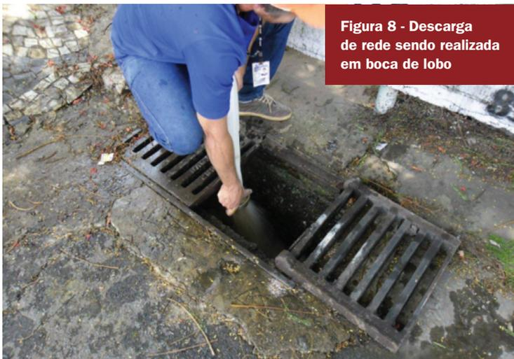
Figura 8 - Descarga de rede sendo realizada em boca de lobo
