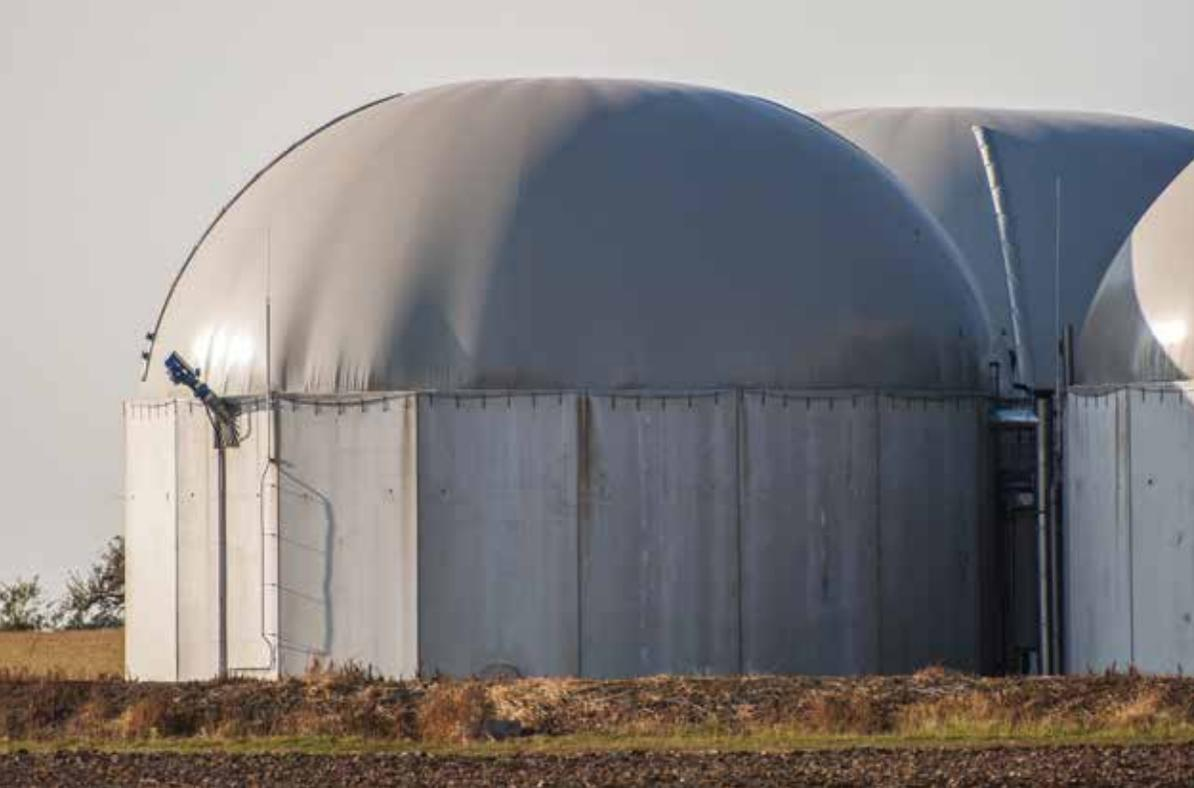
**Figura 8** - CSTR de uma planta de biogás.
