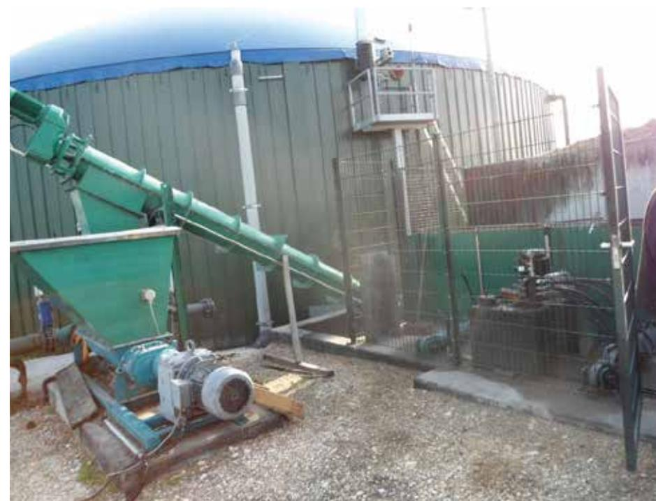
**Figura 5** – Sistema de introdução de substratos sólidos utilizados em um digester de mistura completa. Fonte: Arquivo Methanum.
