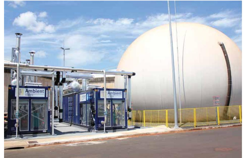
**Figura 31** – Destaque para os grupos geradores instalados na ETE de Ribeirão Preto, SP. Fonte: GUASCOR, 2011.
