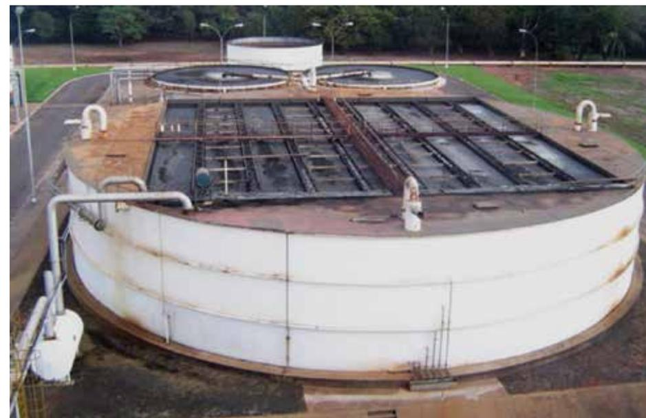
**Figura 24** – Sistema de metanização de vinhaça instalado na Usina São Martinho, em Pradópolis, SP. Fonte: Silva, 2015.
