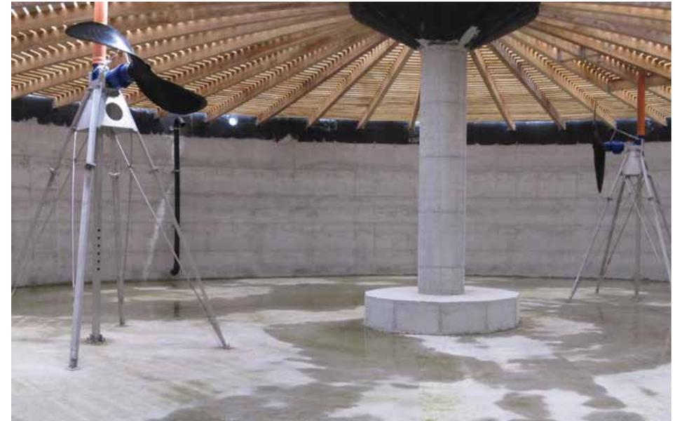
**Figura 7** – Vista da parte interna de um reator CSTR com destaque para os agitadores submersíveis. Fonte: KSB, 2015.
