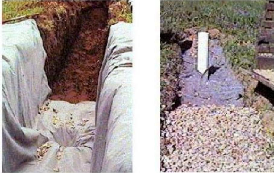
**FIGURA 7:** Construção de trincheiras (NAKAZONE, 2005).
