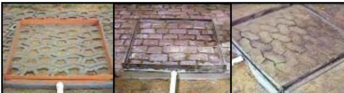
**FIGURA 6:** Exemplos de pavimentos porosos: pavimento de paralelepípedos, de blocos de concreto e de blocos vazados (NAKAZONE, 2005).
