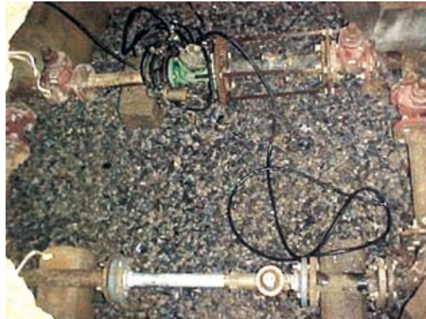
Figura 13 – Exemplo de válvulas em paralelo com diâmetros diferentes
