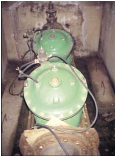
Figura 14 – Exemplo de válvulas instaladas em série (diâmetro 10")
