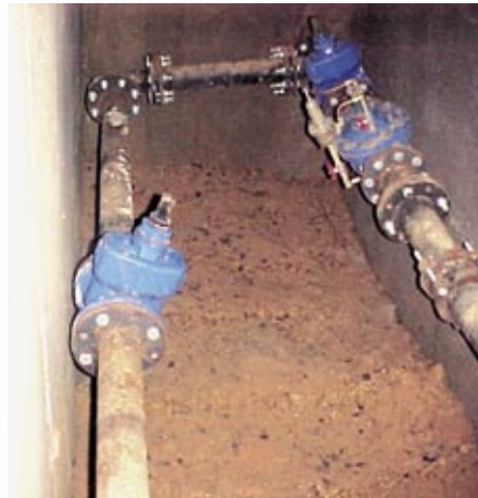
Figura 22 – Instalação inadequada de VRP
