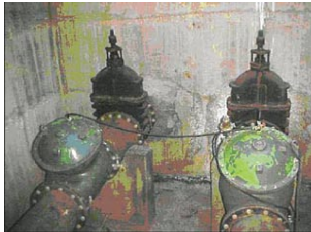
Figura 12 – Exemplo de válvulas em paralelo com diâmetros iguais
