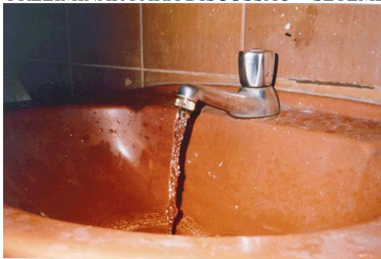
Figura 14: Torneira quebrada em indústria mostrando a displicência dos usuários com o uso da água
