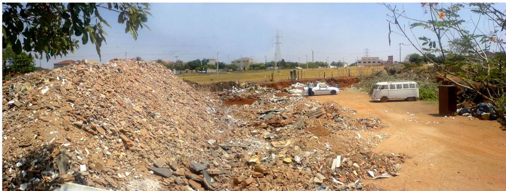
**Exemplo de Aterro de RCD classe A – NBR 15.113/2004**
