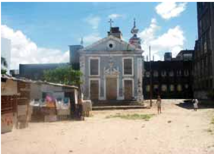
Pilar: ocupação existente.
