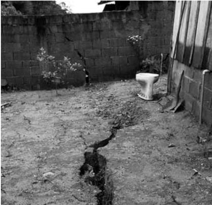
Foto 5.6: Fendas no solo e fissuras na parede
