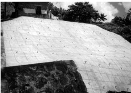
Foto 9.7: Impermeabilização com tela argamassada (Coutinho et al, 2005)
