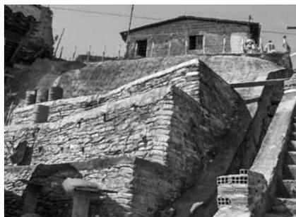
Foto 9.15: Muro de solo-cimento ensacado.
