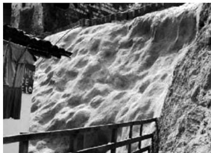
Foto 9.6: Impermeabilização com cimento (Coutinho et al, 2005)
