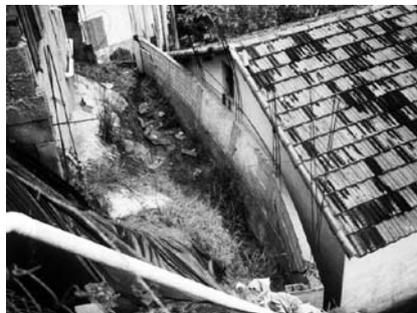
Foto 5.11: Embarrigamento no pé do talude
