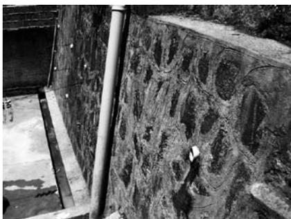
Foto 9.13: Muro de concreto ciclópico. (Coutinho et al., 2005)
