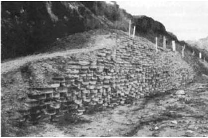
Foto 9.17: Muro de solo-pneu (Geo-Rio, 2000).
