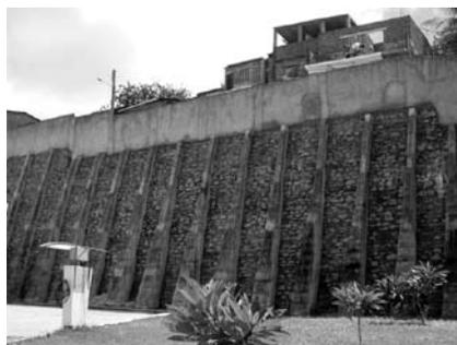
Foto 9.14: Muro de concreto ciclópico com contraforte (Santana, 2006)
