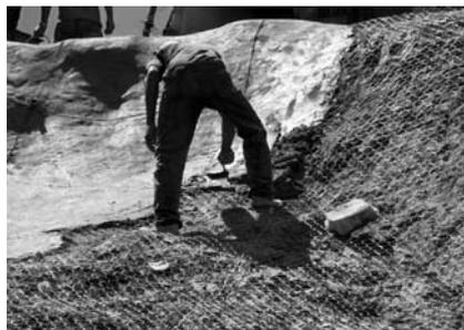
Foto 9.8: Impermeabilização com tela argamassada (Coutinho et al, 2005)
