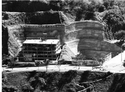
Foto 9.22: Exemplo de muro de contenção executado com solo grampeado - Rio de Janeiro (Sayão, 2007)
