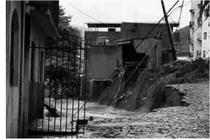
Foto 7.5: Taludes marginais que sofreram solapamento
