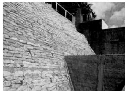
Foto 9.16: Muro de solo-cimento ensacado.
